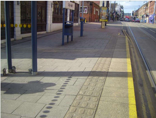
Fotoğraf 3: Tramvay durağında eliptik yüzey uygulaması örneği
