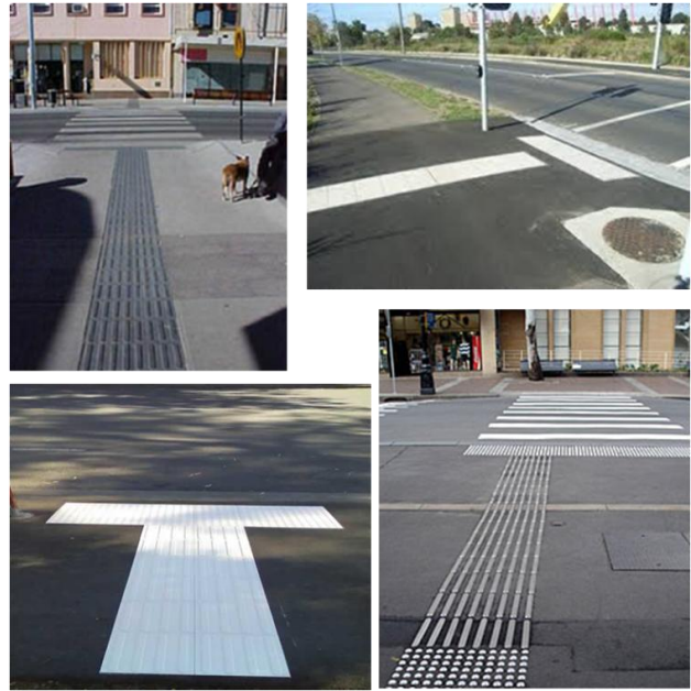
Fotoğraf 1: Yaya geçidine kılavuz izle yönlendirme yapılmalı ve taşıt yolu öncesinde 80 cm derinliğinde ve yaya geçidi genişliğinde uyarıcı yüzeý uygulanmalıdır.
